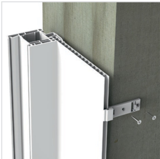
3 Die Lasche mit der Wand verschrauben.
