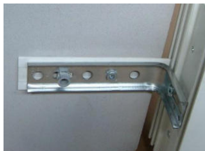
Abbildung 79: Die Kombination aus ISO-Platte und Kunststoffdübel bietet eine thermische Trennung.
