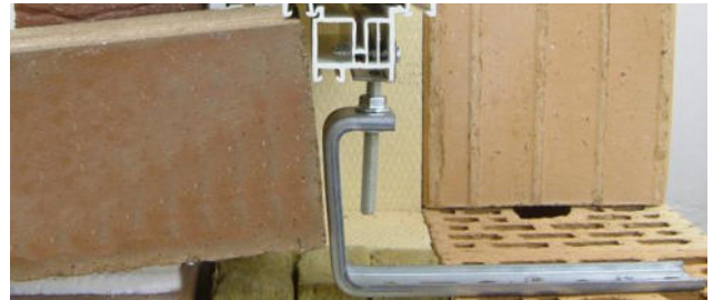
Abbildung 26: WU-Konsole 110-150x220x2,5
