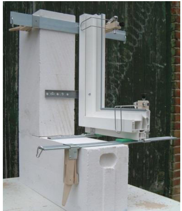
Abbildung 157: Fenstermontage mit der Fenstermontagezwinge
