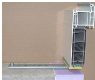
Abbildung 62: Schritt 2 - Verklotzung
