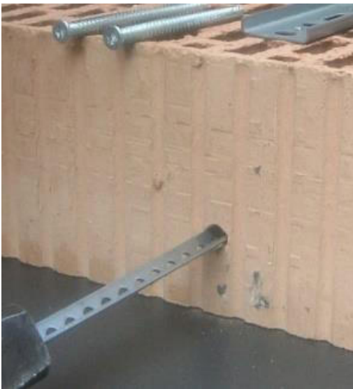
Abbildung 35: Schritt 1 - V-Lochschiene einbringen
