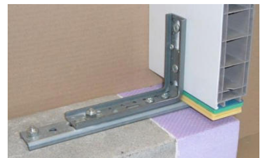
Abbildung 63: Schritt 3 - Verschrauben des Winkels
