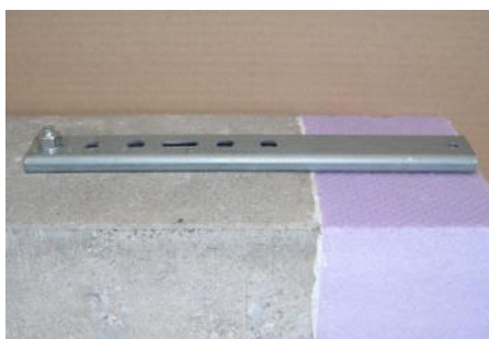
Abbildung 61: Schritt 1 - Befestigung zur Betonsohle
