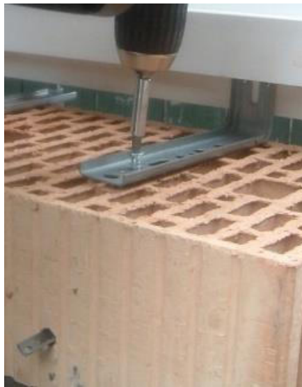
Abbildung 36: Schritt 2 - Anker mit V-Lochschiene verschrauben
